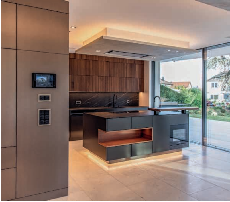
Über die KNX-Taster werden auch in der Küche Licht, Raumtemperatur und Audio gesteuert.
